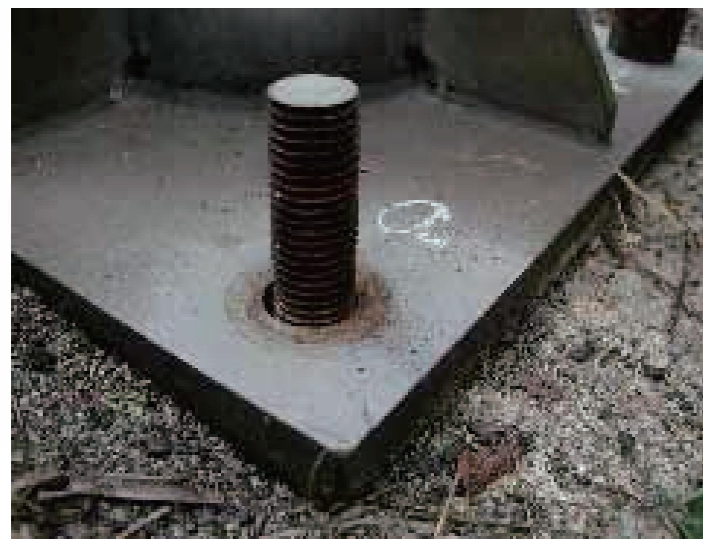
取付け用アンカーボルトの腐食、減肉化
