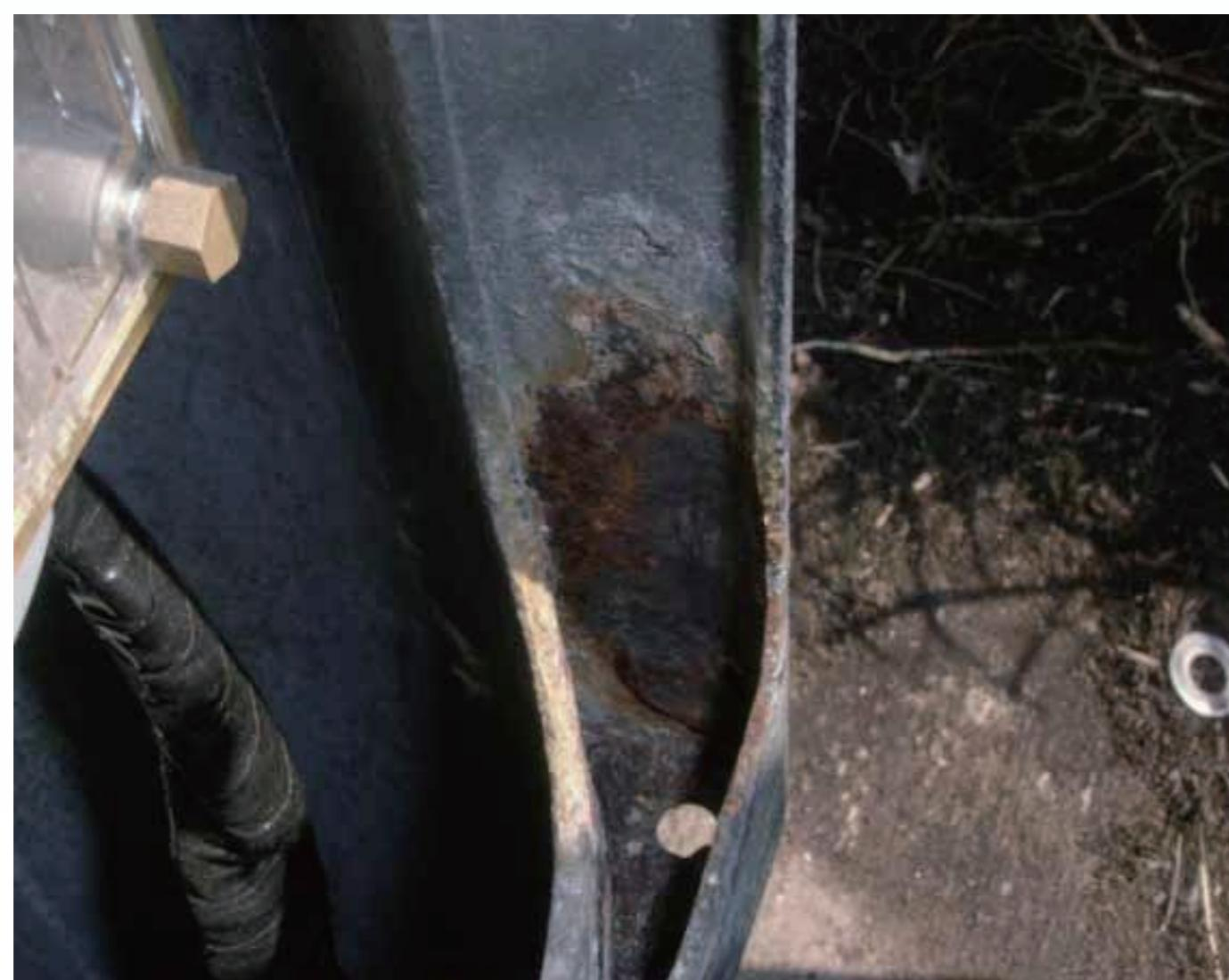
点検口下部に母材の腐食が見られる
